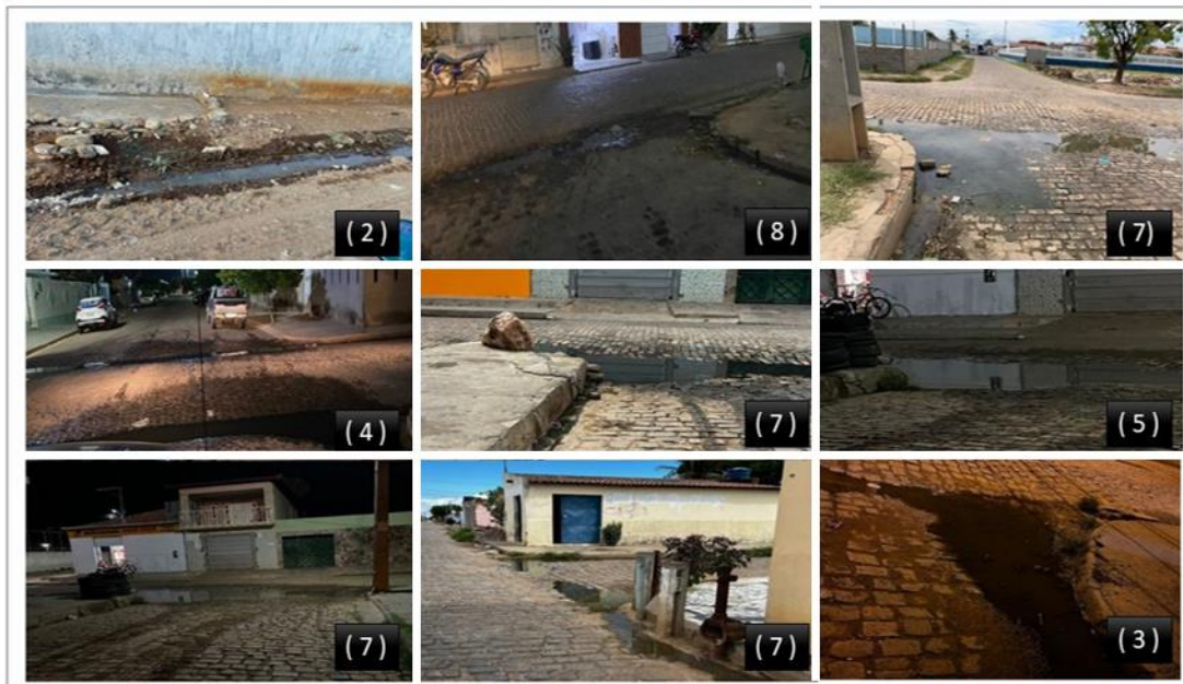
Figura 4: Demonstração de situações de falta de drenagem urbana e esgotamento sanitário nos bairros avaliados pelo estudo.
